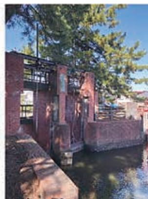
新庄排砂水門
