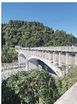
左岸連絡水路橋
