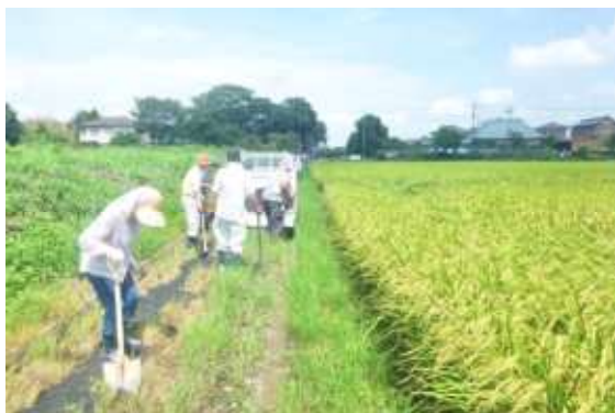
定期点検・補修 (砂利入れによる路面補修)
