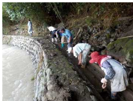
用水路の土砂撤去
