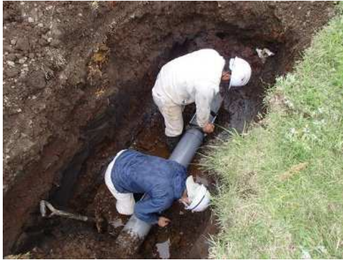
パイプラインの復旧
