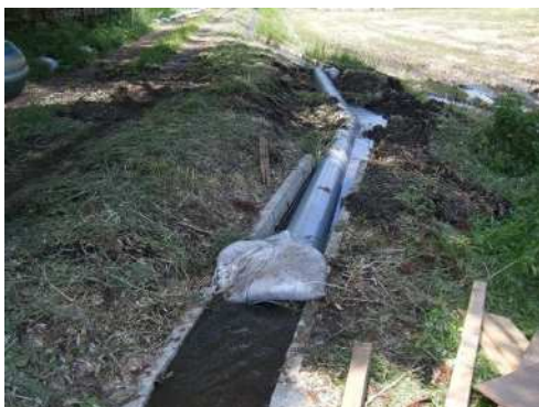
応急措置後の用水路
