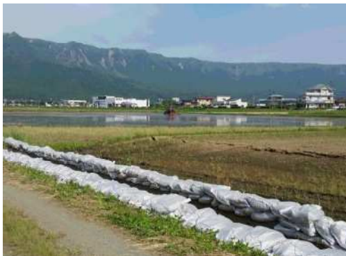
応急措置後の用水路
