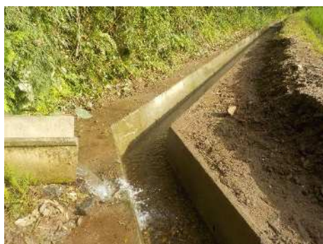
復旧後の水路状況
