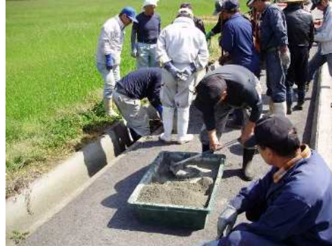
水路の目地詰め
