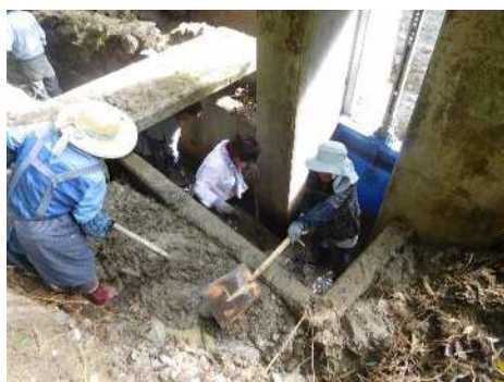
取水ゲートの土砂撤去
