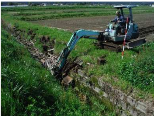
排水路側壁の復旧
