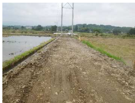
復旧後の農道状況
