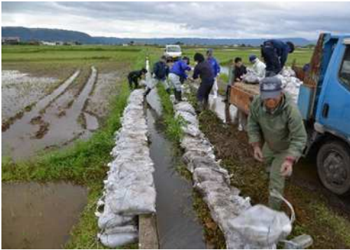
水路への土のう設置
