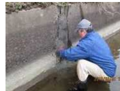
水路のひび割れ補修
