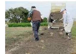
農道の窪みの補修
