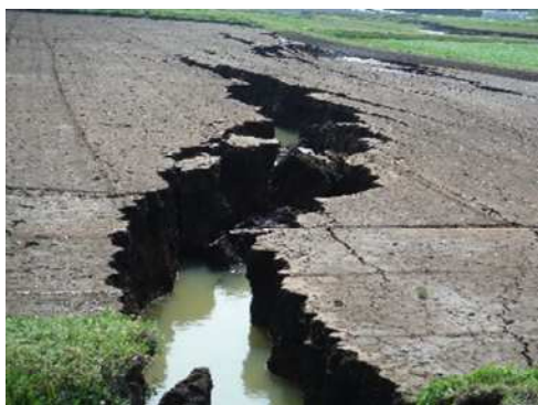
農地を切裂く大きな亀裂
