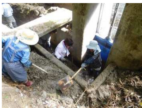
取水ゲートの土砂撤去
