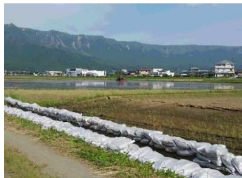
応急措置後の用水路
