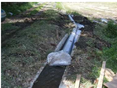
応急措置後の用水路
