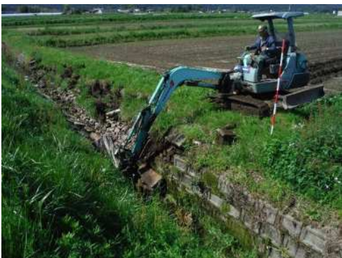
排水路側壁の復旧
