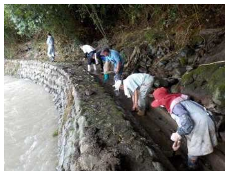
用水路の土砂撤去
