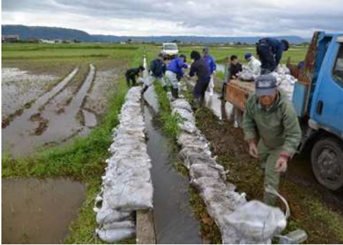
水路への土のう設置
