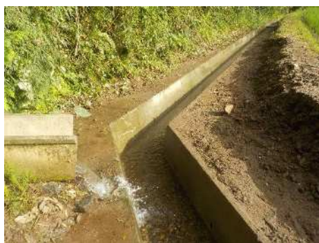
復旧後の水路状況
