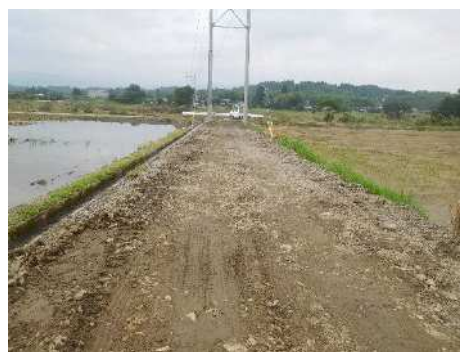
復旧後の農道状況
