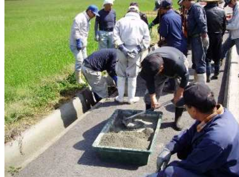
水路の目地詰め
