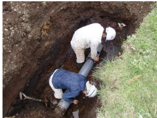
パイプラインの復旧
