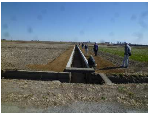
長寿命化工事
