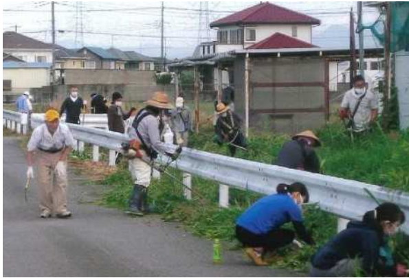
排水路の草刈り
