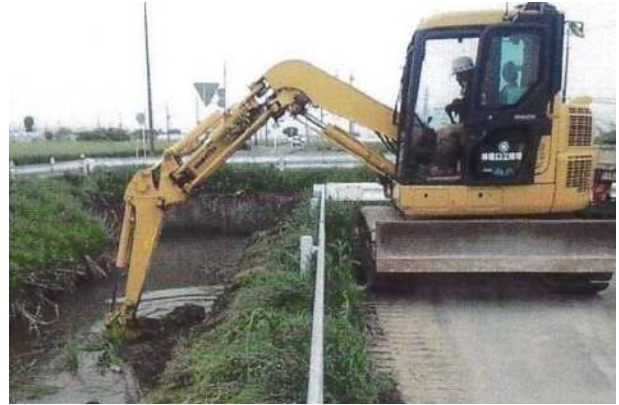
重機による排水路の浚渫
