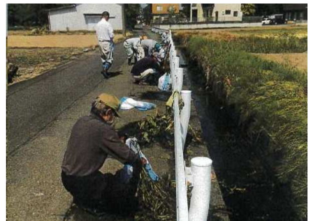
排水路の泥上げ
