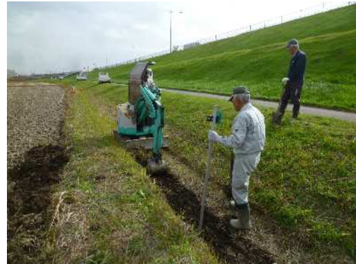
土水路の泥上げ
