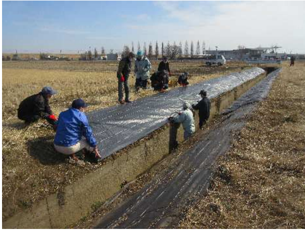
防草シート張り
