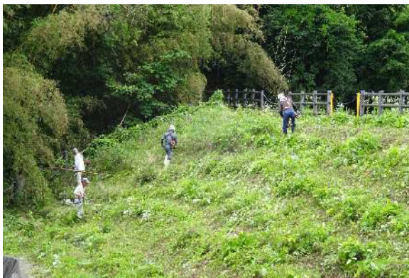
ため池法面の草刈り
