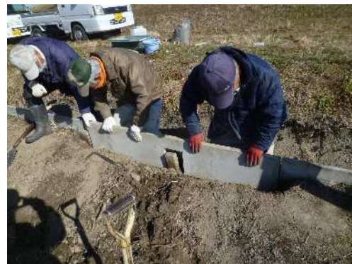
用水路の補修
