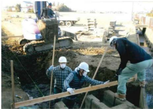
水路整備工事（直営施工）
