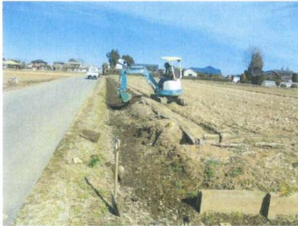
水路の浚渫作業
