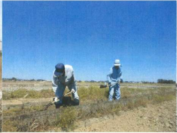
水路の泥上げ
