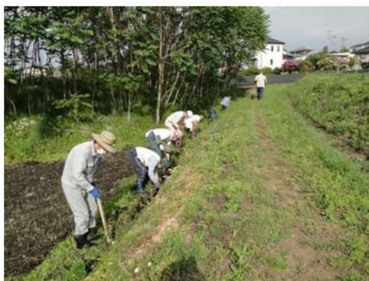
用水路の泥上げ
