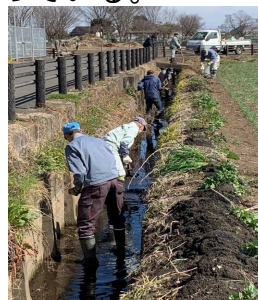
水路の泥上げ作業
