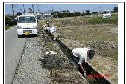
( 水路の泥上げ )
