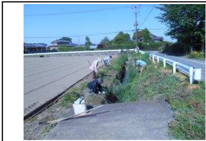
( 水路の泥上げ )
