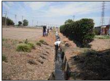
( 水路の泥上げ )
