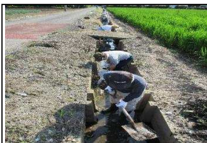
( 水路の泥上げ )
