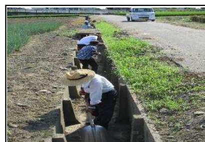
( 水路の泥上げ )
