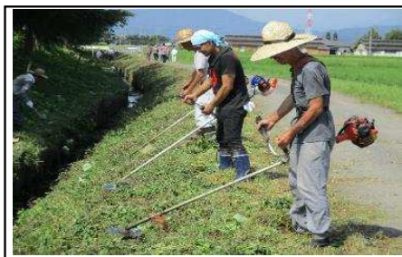
( 水路法面の草刈り )
