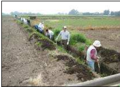
( 水路の清掃、泥上げ )
