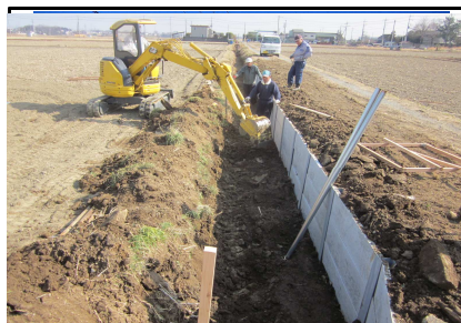
( 用水路の補修整備 )
