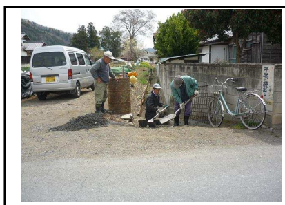
( 水路の清掃作業 )
