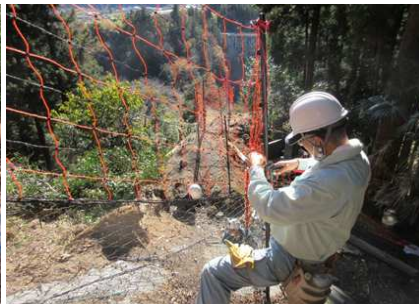
(広域電気柵の修理風景)
