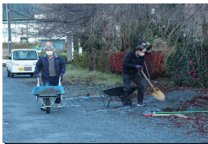
(簡易道路補修活動)
