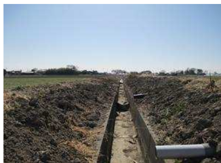
(堀さらい後の水路)
