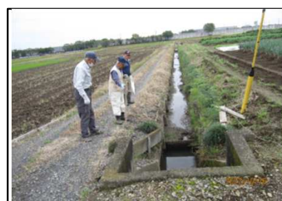
( 水路の機能診断 )
