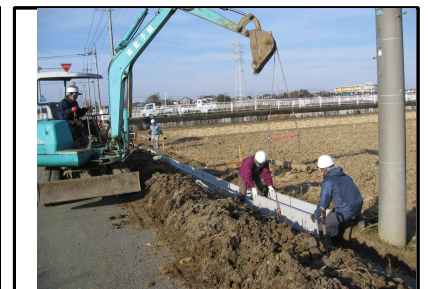
( U字溝敷設工事 )
