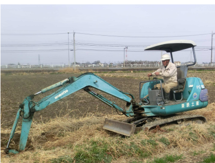
(重機による排水路の浚渫)
