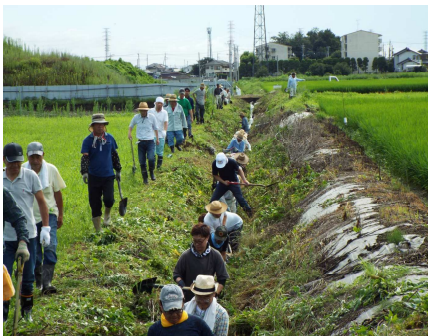
( 排水路の泥上げ )
