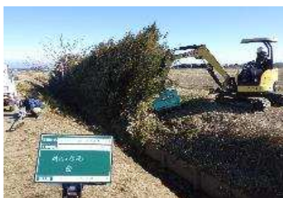
（排水路の草刈り）
