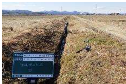
（排水路の浚渫）
