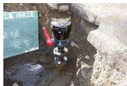
（パイプライン空気弁の更新）
