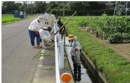
（コンクリート水路の泥上げ 川端南）
