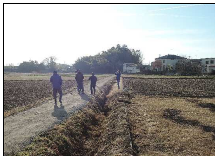
農道の砂利敷き補修
