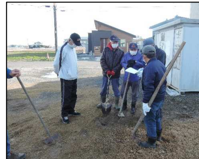
( 作業前の安全確認 )
