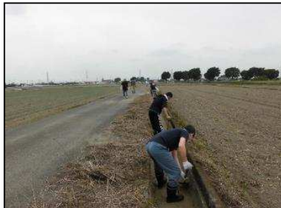
( 水路の泥上げ )
