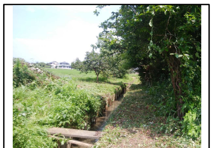
( 法面の雑木伐採 )
