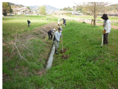
( 水路泥上げ作業 )
