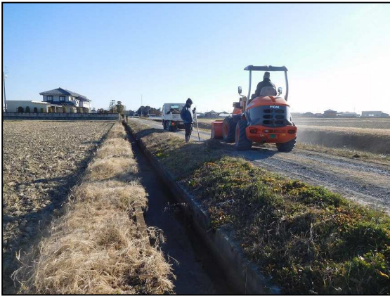
レンタルした重機による砂利敷均し
