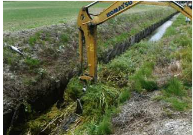
重機による排水路の浚渫
