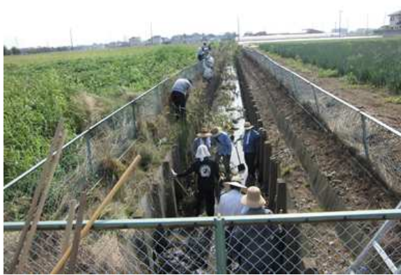
排水路の泥上げ
