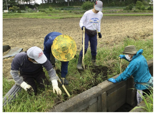
水路側壁の裏込め材の充填
