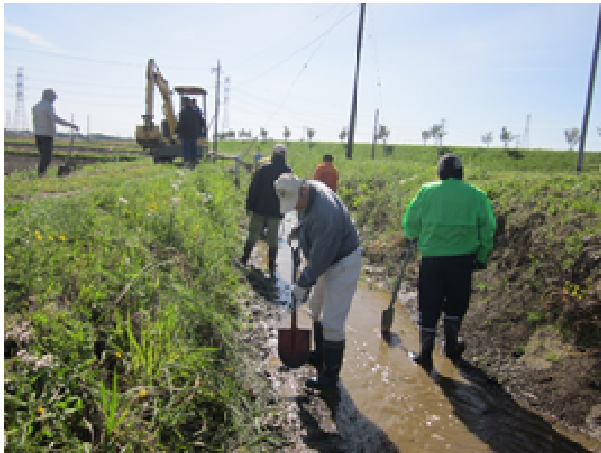
用水路の泥上げ
