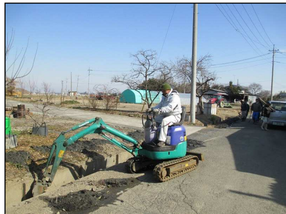
重機による水路浚渫
