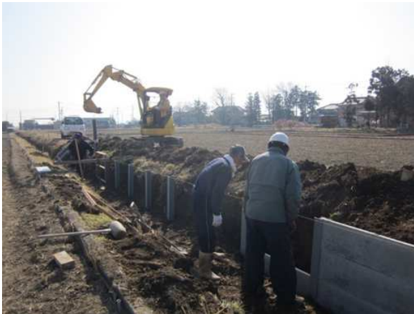
コンクリート土留め板敷設
