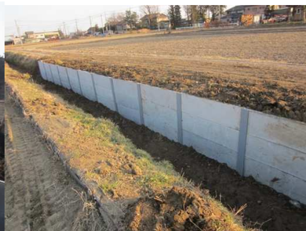
コンクリート土留め敷設完成
