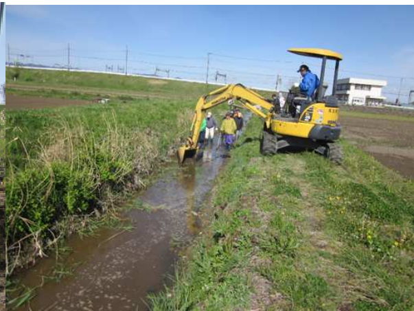
重機を使った泥上げ
