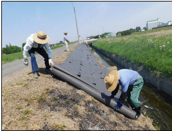
水路法面への防草シート張り (イワダレソウの植栽準備)
