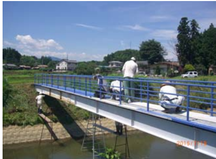
(送水管(橋梁)の塗装作業)
