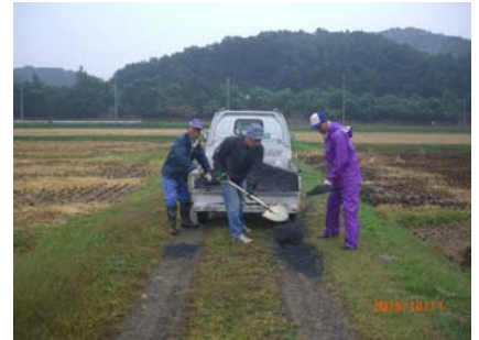
(農道の補修作業)
