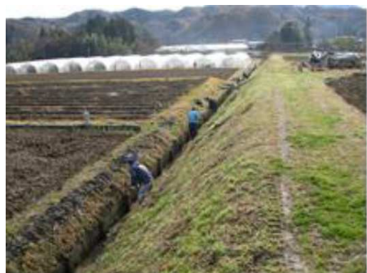
水路の泥上げ作業
