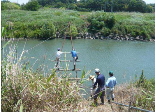
(ポンプ場の補修)
