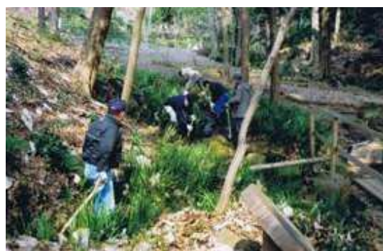
開水路の維持・泥上げ
