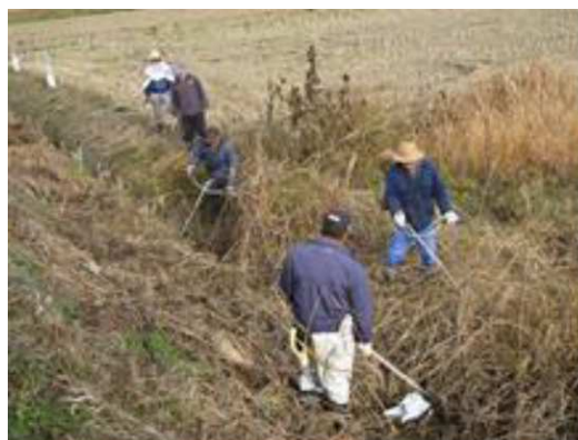
水路法面の草刈り作業
