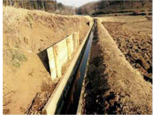
排水路改修工事
