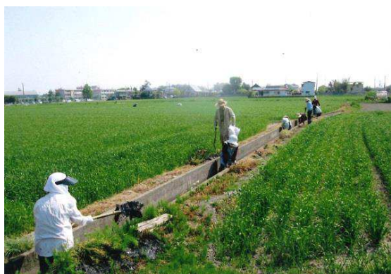
(水路の泥上げ)
