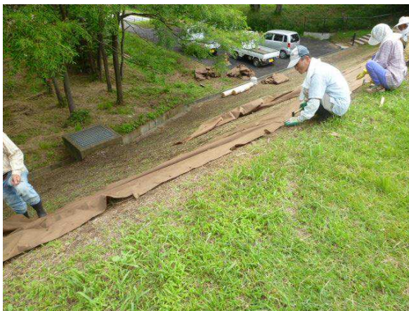
ため池堤体での植栽作業
