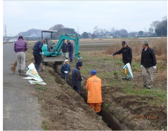
水路の泥上げ
