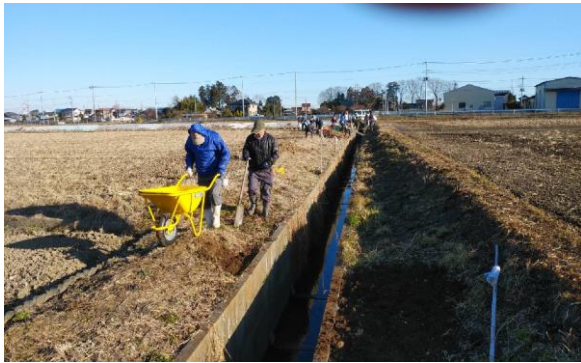
排水路法面補修作業
