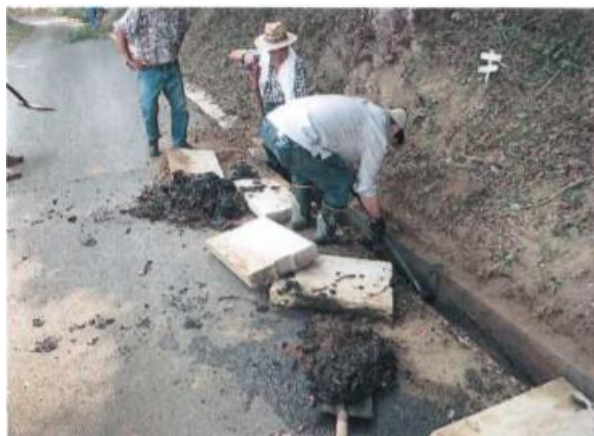
側溝の泥上げ
