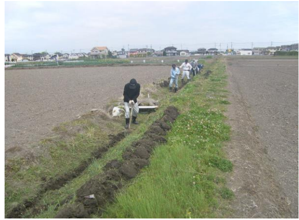
水路の泥上げ
