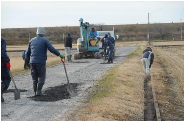
農道・用水路の補修
