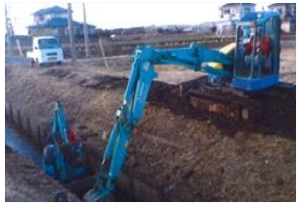
水路の泥上げ
