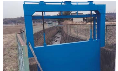
(堰のペイント塗装)
