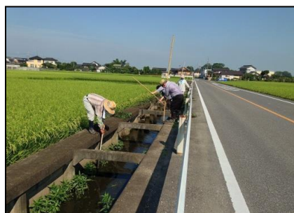
( 水路の点検・清掃 )
