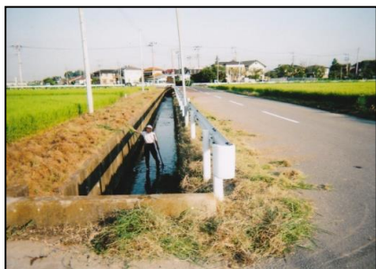
( 水路の点検・清掃 )
