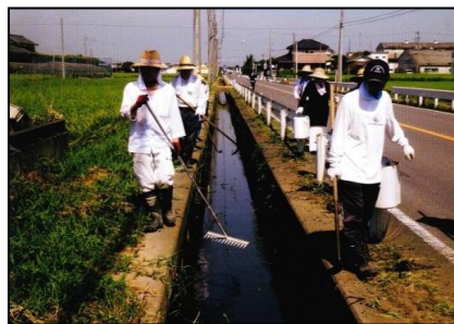
( 水路の点検・清掃 )
