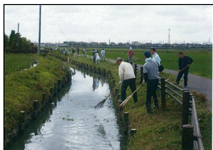
( 水路の点検・清掃 )
