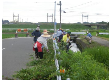
( 水路の点検・草刈 )
