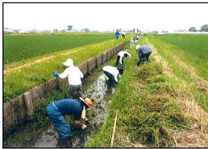
( 水路の点検・草刈 )
