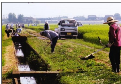
( 水路の点検・草刈 )
