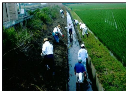
( 水路の点検・草刈 )
