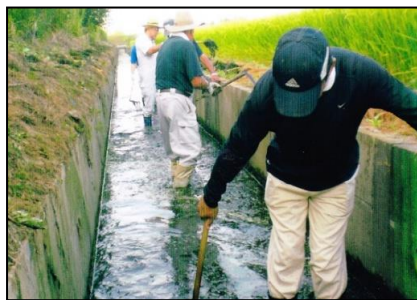
( 水路の点検・清掃 )
