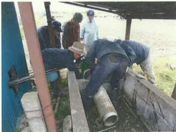
揚水機の点検・設置
