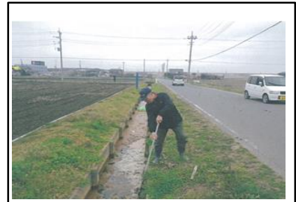
( 水路の泥上げ )
