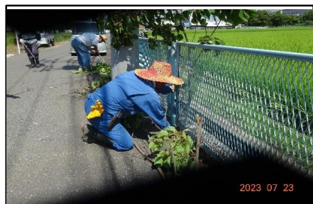
(一般道に面した排水路)
