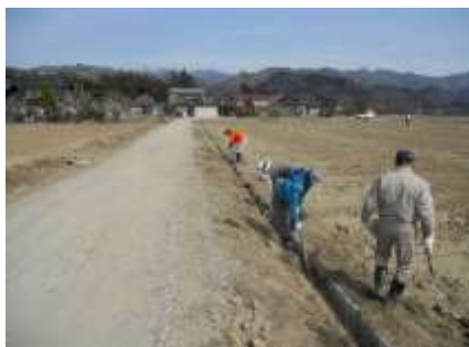
(開水路の泥上げ作業)
