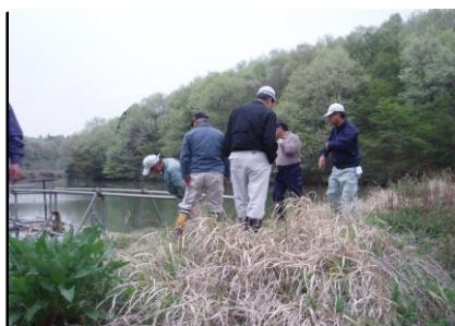
(ため池の点検)
