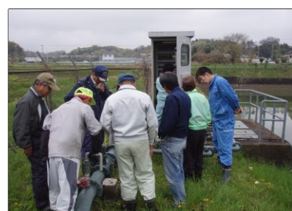
(揚水機の維持管理状況)
