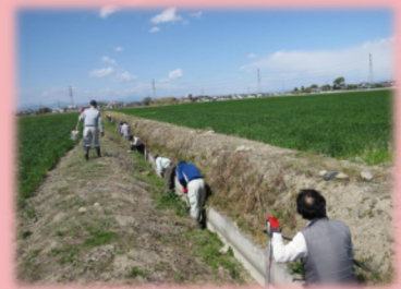
水路の泥上げ
