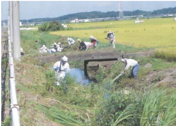
水路の草刈・泥上げ
