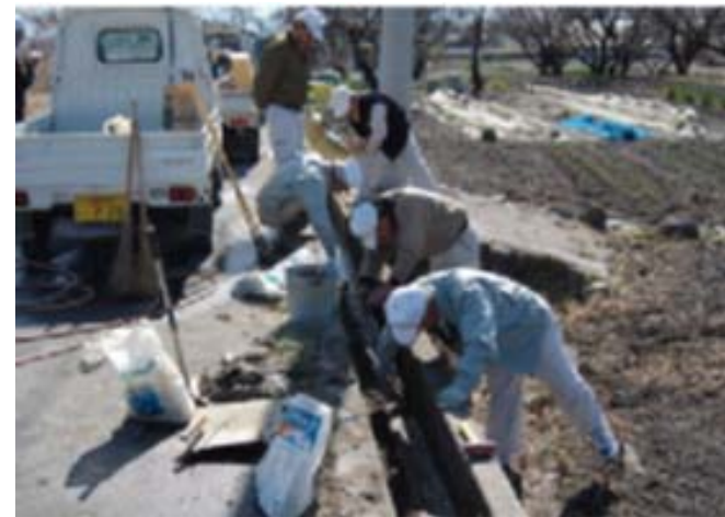
【水路目地詰め、表面補修】
