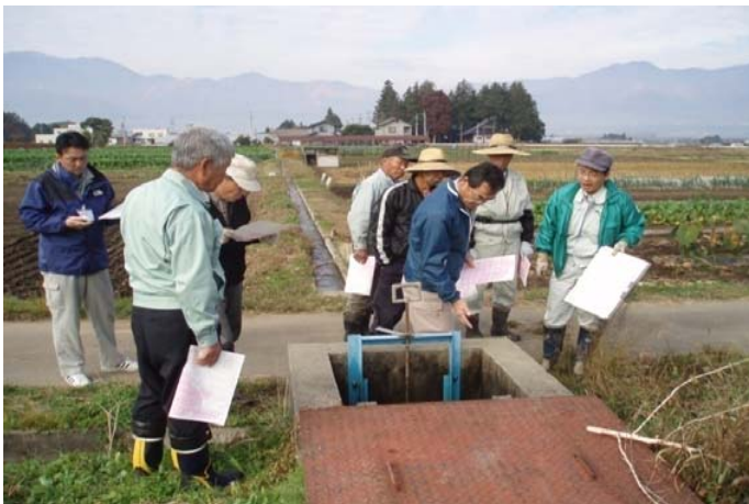
【開水路の点検】
