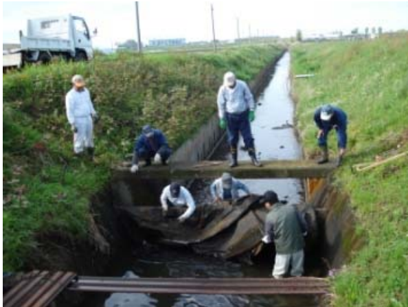
【破損したゴム堰の補修】
