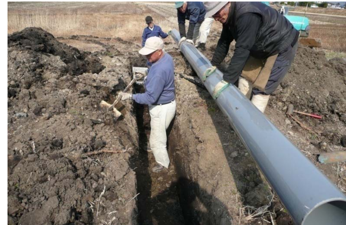
【破損したパイプラインの部分的な改修】
