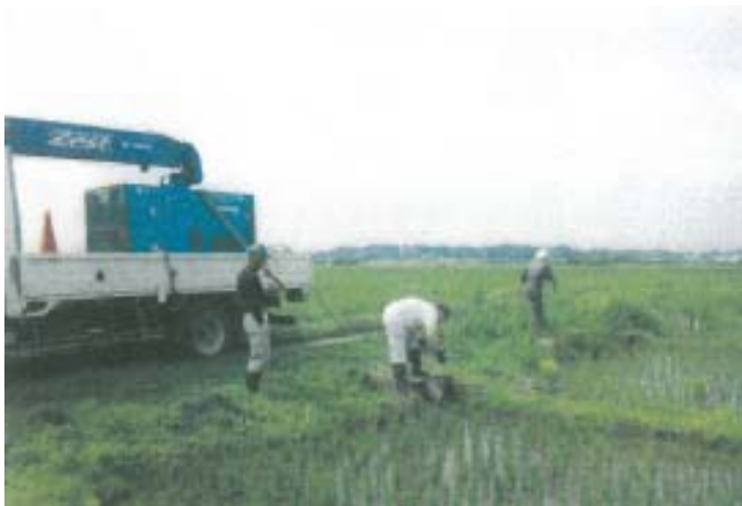
【パイプライン内の清掃】
