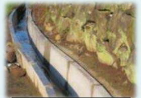
素堀り水路からの更新
