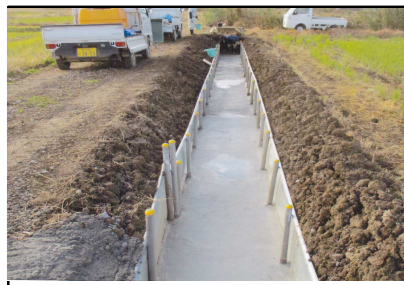
( 水路補修工事 )
